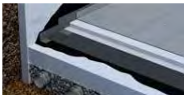
Solera amb barrera de radó Sistema RAD3 180-40 P Elast
