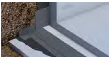
Llosa de fonamentació amb barrera de radó Sistema RAD1 POLYDAN® 180-40 P Elast
